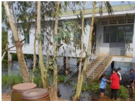
Trạm bơm nước khu A2
